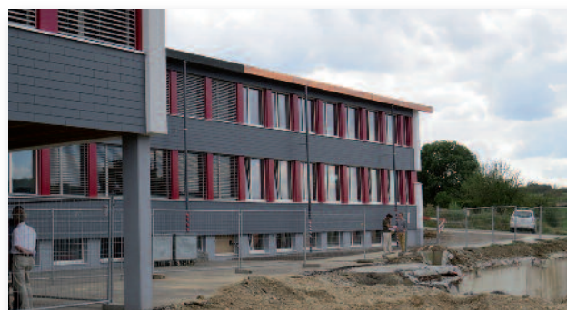
Bestehendes Schulhaus und neuer Anbau: Nahtloser Übergang.
